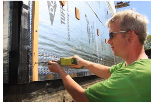
Thermal Shell Retrofit
